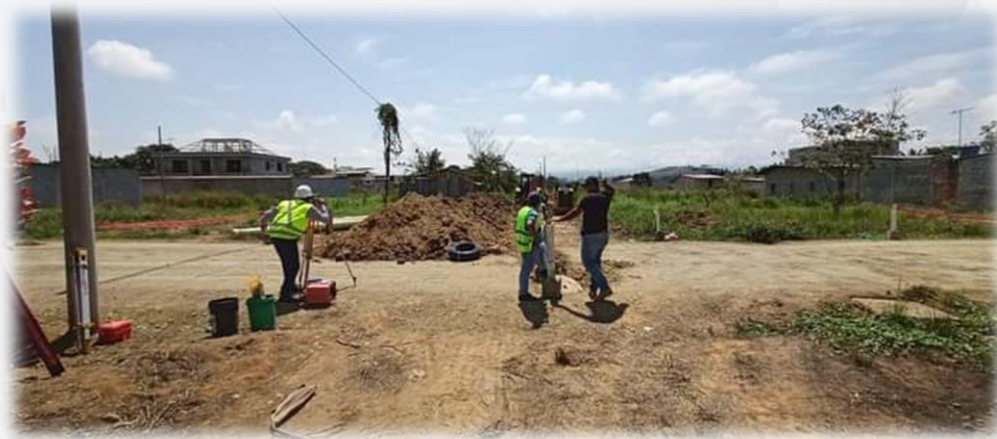
Levantamiento topográfico -excavación a máquina.
