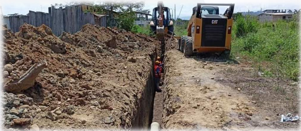
Excavación a máquina e instalación de tubería
